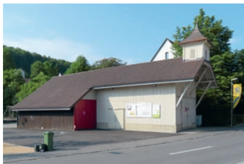
4.1 VORHER: Das alte Feuerwehrmagazin wartet auf seine neue Nutzung
