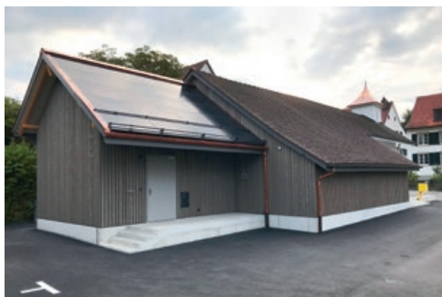
4.4 NACHHER: Der bestehende Schopf wurde umgebaut und durch einen ansprechenden Anbau mit Solardach ergänzt
