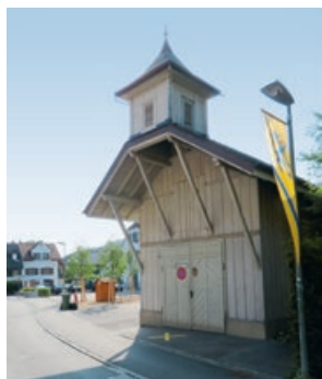
4.5 VORHER: Das ehemalige Feuerwehrmagazin mit dem aufgesetzten Dachreiter, der zum Aufhängen und Trocknen der Feuerwehrschläuche diente
