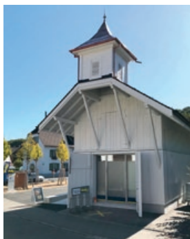
4.6 NACHHER: Die Tore stehen wieder offen. Die eindrückliche Holzarchitektur konnte erhalten und fachgerecht renoviert werden
