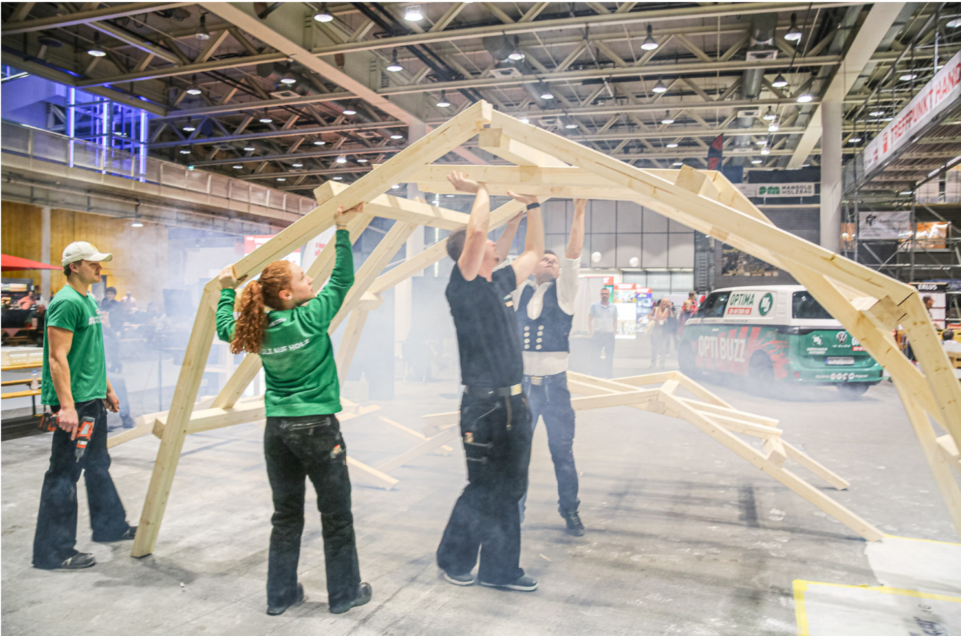
Die Lernenden von PM Mangold (in Grün) errichten mit den Betreuern im Nebel von einer Nebelmaschine die Leonardo-Brücke.
