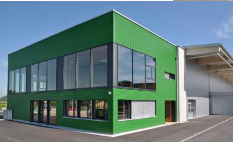
< Neubau Produktionshalle und Gruppenräume PM Mangold Holzbau AG in Kaiseraugst, Baujahr 2012
