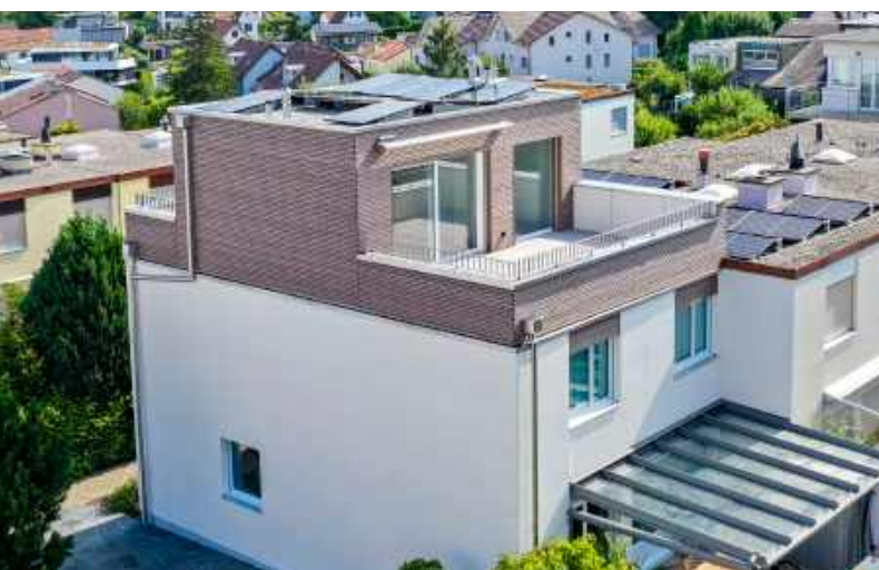
↓ Aufstockung Reihenhaus in Oberwil, Baujahr 2023
