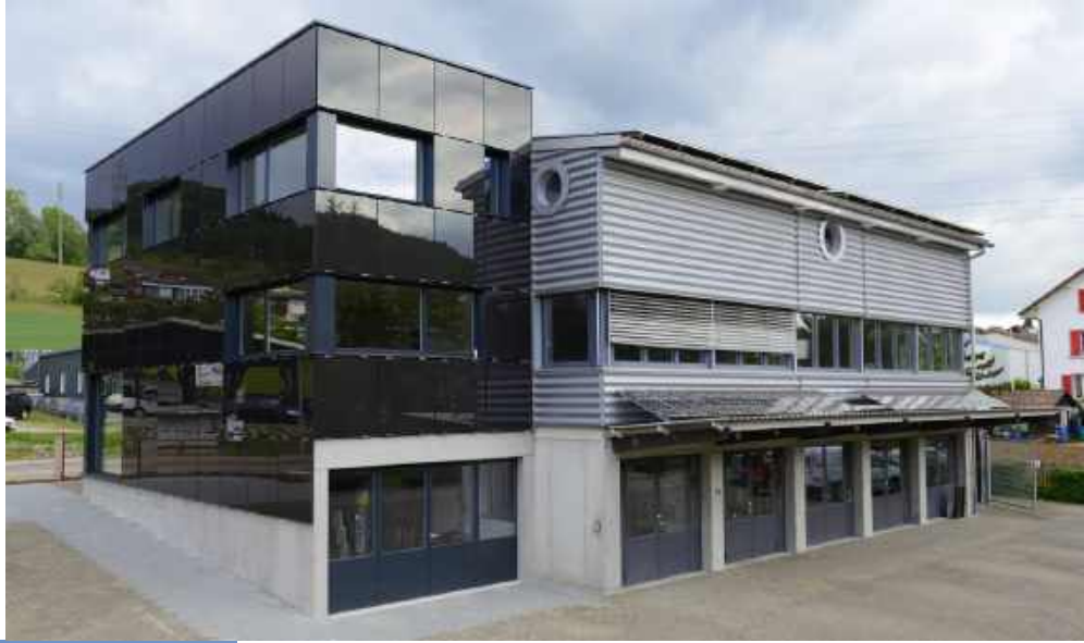
Anbau an bestehenden Gewerbebau in Ormalingen, Fassadenbekleidung aus Photovoltaikmodulen, Baujahr 2014 >
