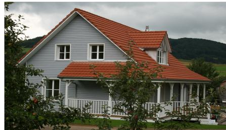
Die Produktion findet dadurch nicht mehr auf der Baustelle, sondern in unseren Werkhallen statt. Auf dem Bauplatz werden lediglich das Fundament, die Montage der Elemente sowie Ausbaurbeiten ausgeführt.
